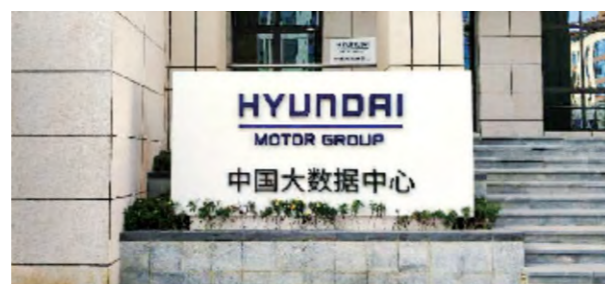
现代汽车集团中国大数据中心
