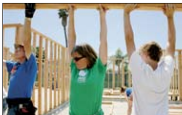
建筑房屋、修建房屋爱心项目
