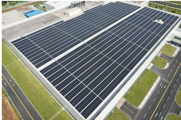
HTWO 广州工厂屋顶光伏系统
