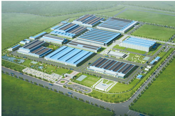
山东现代威亚太阳能光伏发电站
