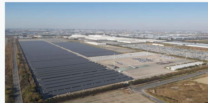
江苏悦达起亚第三工厂光伏系统
